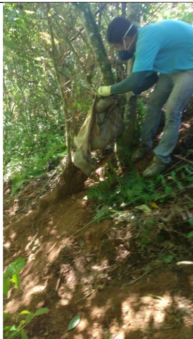
Figura 69: Cobertura com solo nos locais sobre a pilha de resíduos aflorados, que não puderam ser removidos, pois instabilizariam o terreno.
